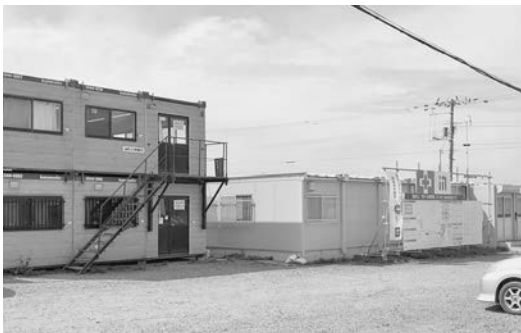
上平牧場宿舍解体後に設置された作業所など
