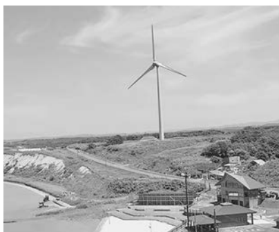
順調に稼働する町営風車
