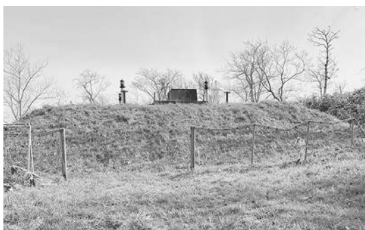
老朽化した苫前地区臨海配水池
