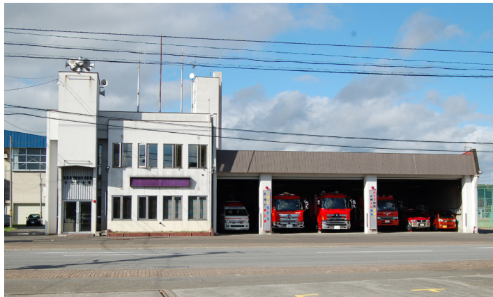
古丹別支署庁舎 立替予定
