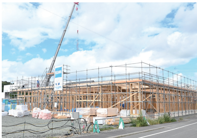
建設工事中の古丹別地区 多世代交流・多機能型拠点施設
