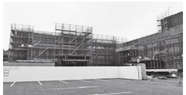
苦前地区コミュニティセンターと役場庁舎の耐震化工事は順調に進んでいる
