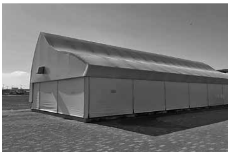
改修工事の対象となった未来港公園の管理棟
