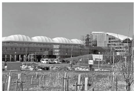
ふわっと大規模改修工事が進む
