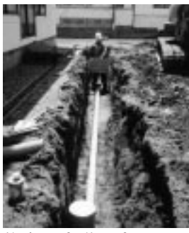
住宅下水道工事の風景
