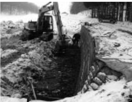
力昼三毛別線道路災害復旧による道路補強土壁工事
