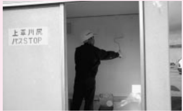
上平川尻バス停の塗装作業の様子
