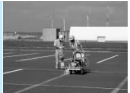
196台分の区画線を整備する様子
