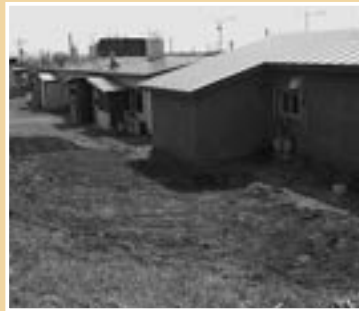
不要木の撤去が終わり整地された様子
